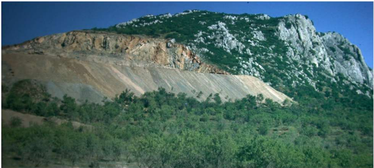
Figura 16. Vista general de la Sierra del Castillo con la sección de la Cantera.
